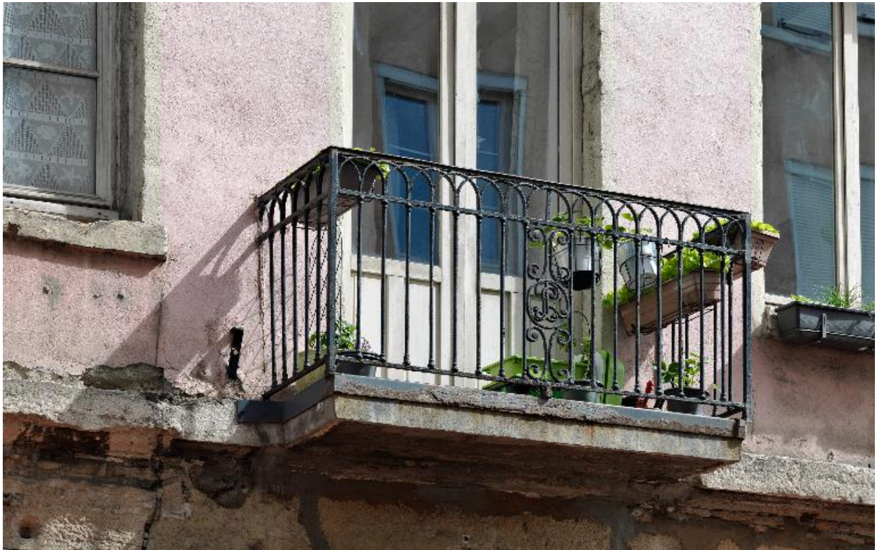
Élévation sur rue, détail du balcon
