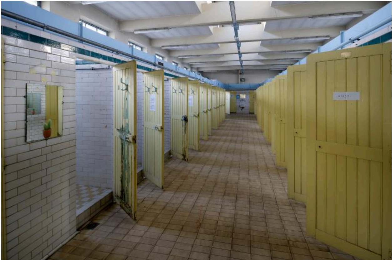
Vue d'ensemble des bains douches Flesselles
