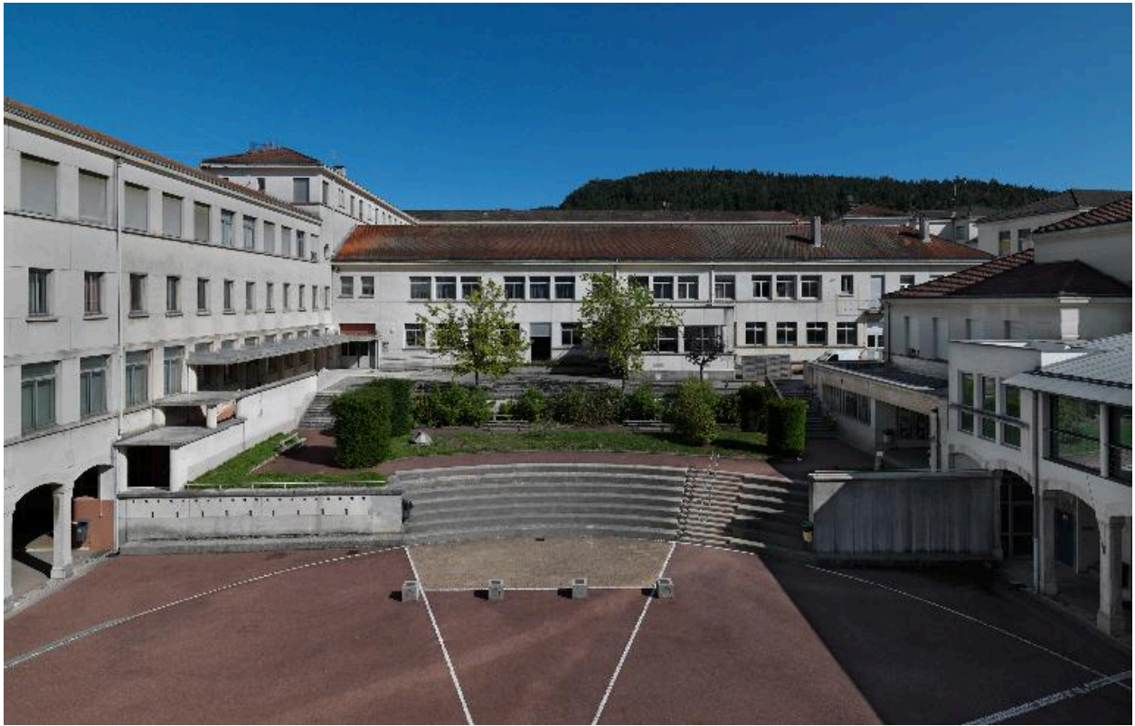
Grande cour, vue d'ensemble depuis le nord-ouest
