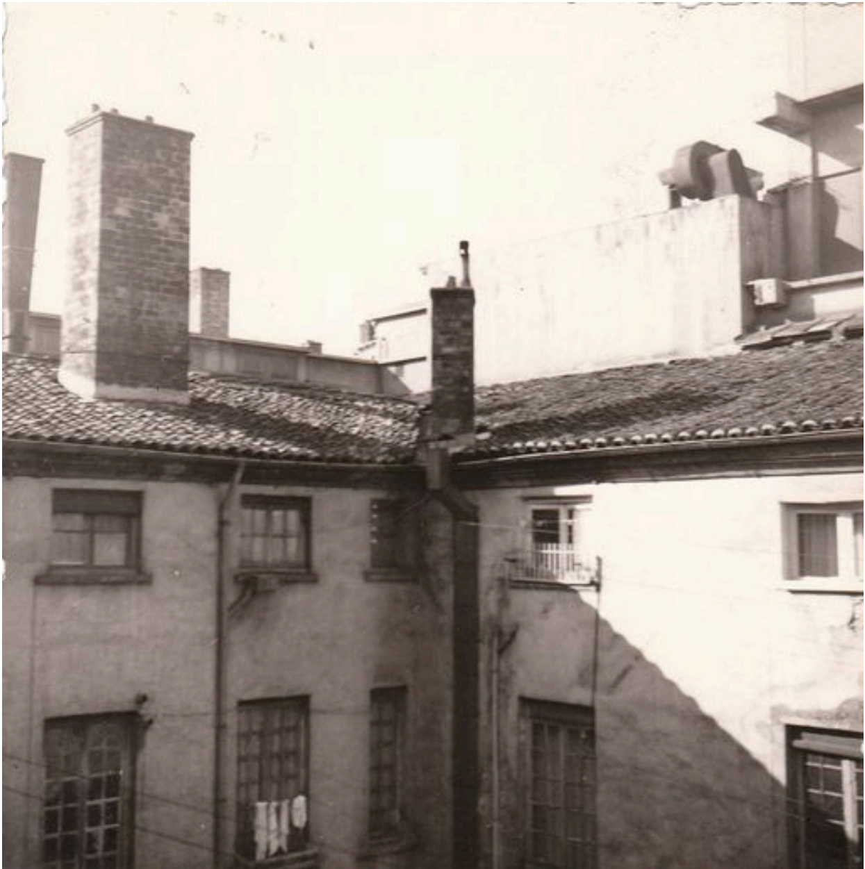
Anciens bâtiments sur cour avant démolition, photographie ancienne, 1970-1971
