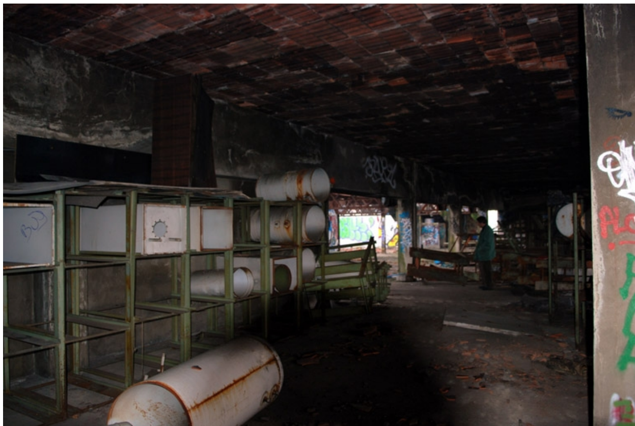
Stockage des chauffe-eaux au 1er étage
