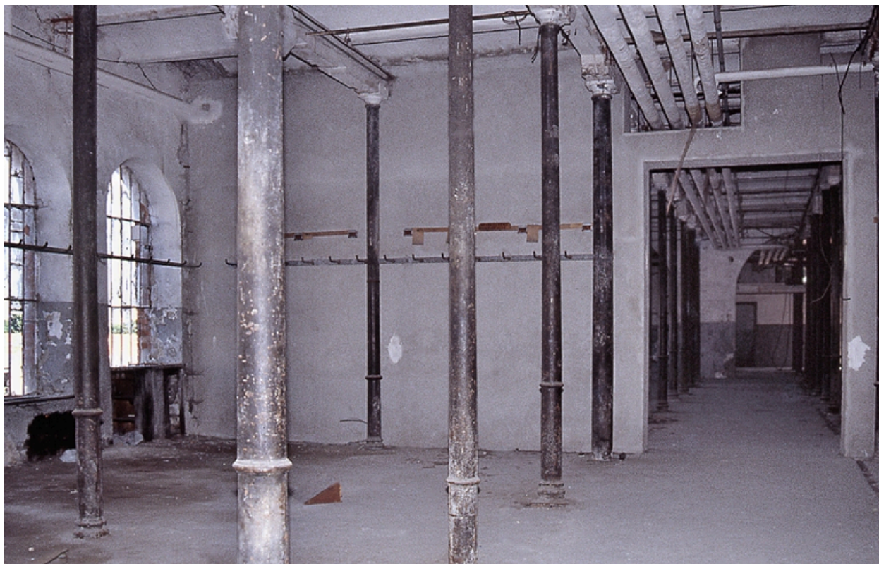
Vue intérieure, poteau fonte
