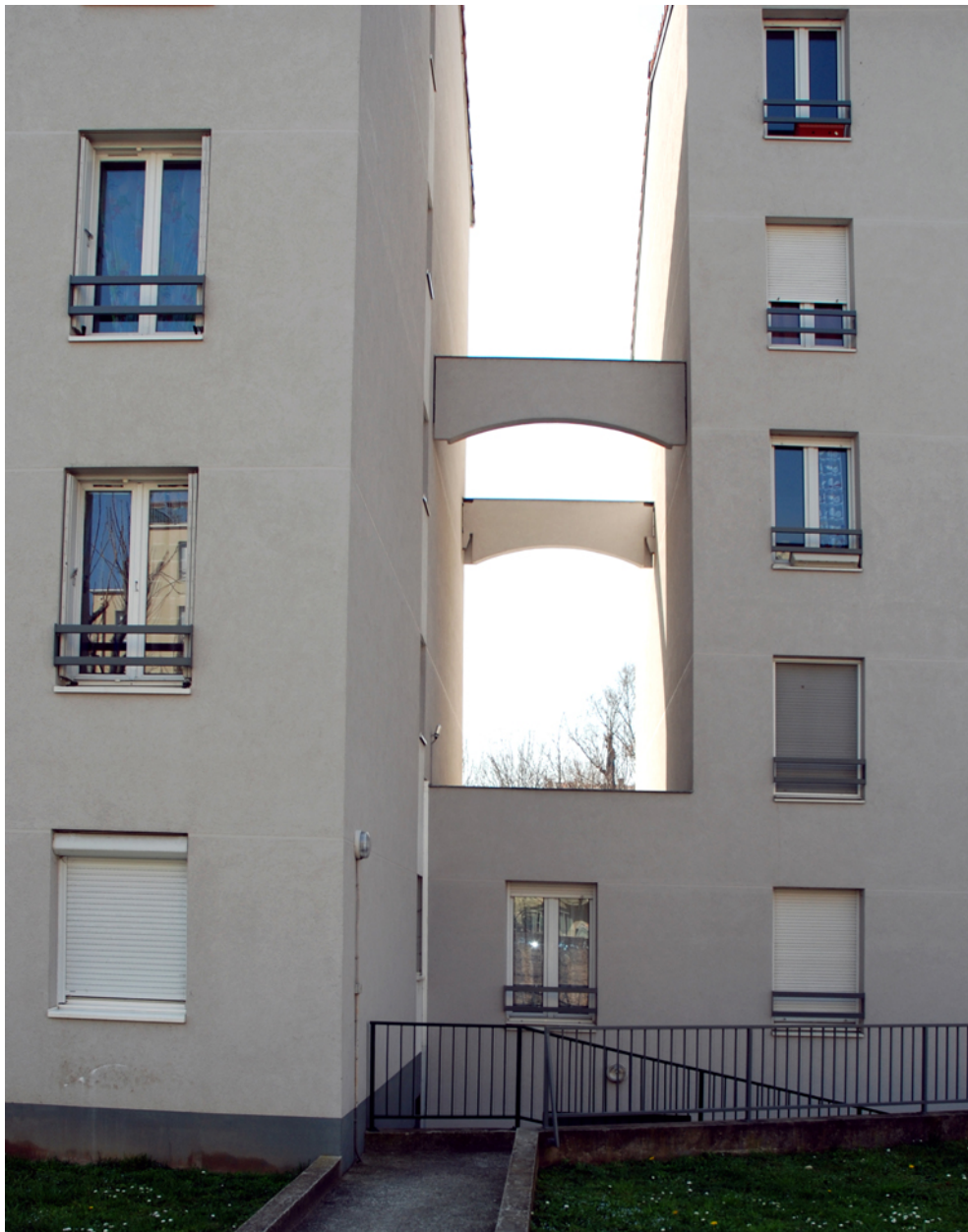
Vue de la liaison entre les deux immeubles
