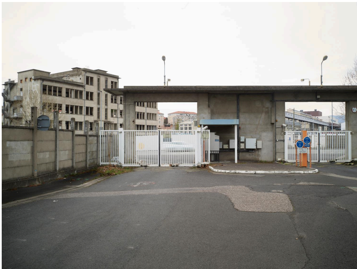
Ancienne porte B163 sur la rue des Planchettes, depuis l'intérieur du site. De l'autre côté de la rue, sur la gauche, le bâtiment C1.
