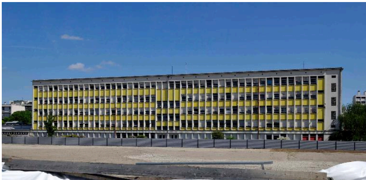
Bâtiment principal, élévation postérieure
