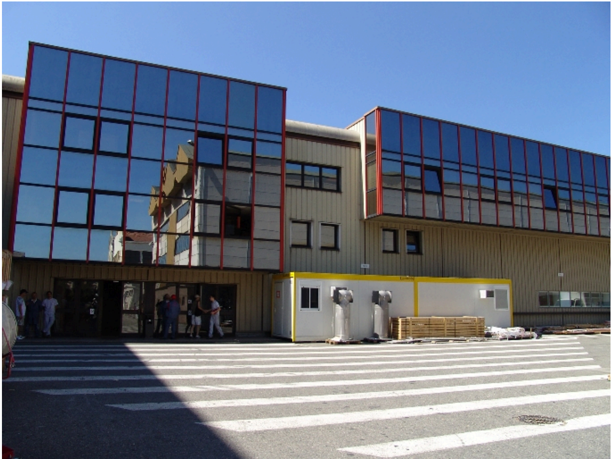
Blocs vitrés sur la façade nord des ateliers de fabrication BHT1
