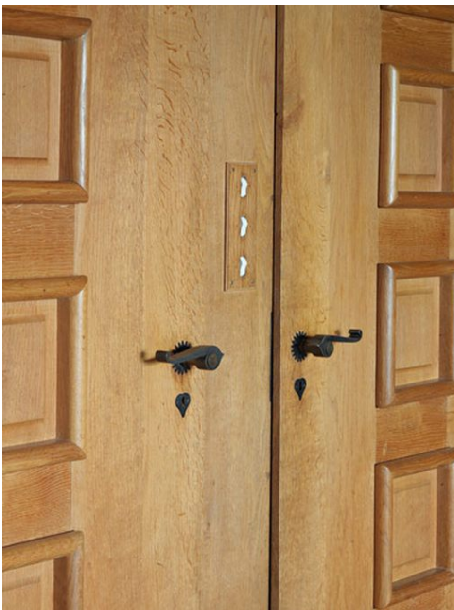
Détail de portes de placards
