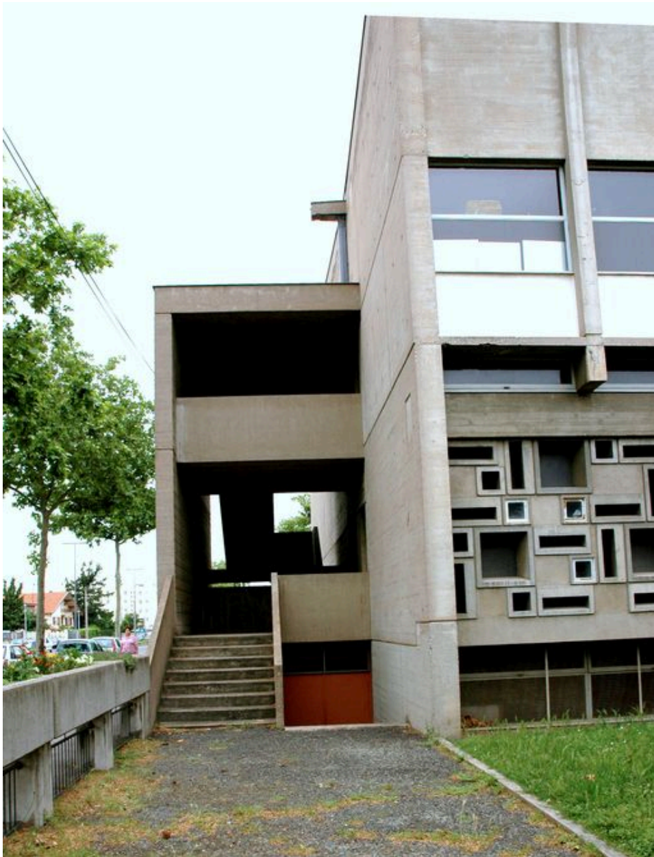
L'escalier construit contre la façade latérale sud
