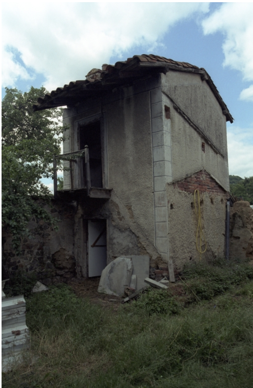
Marcilly-le-Châtel, les Grandes Rases (1987 A1 56), type A1. Vue d'ensemble de trois-quarts droite du logis et de la grange-étable attenante.
