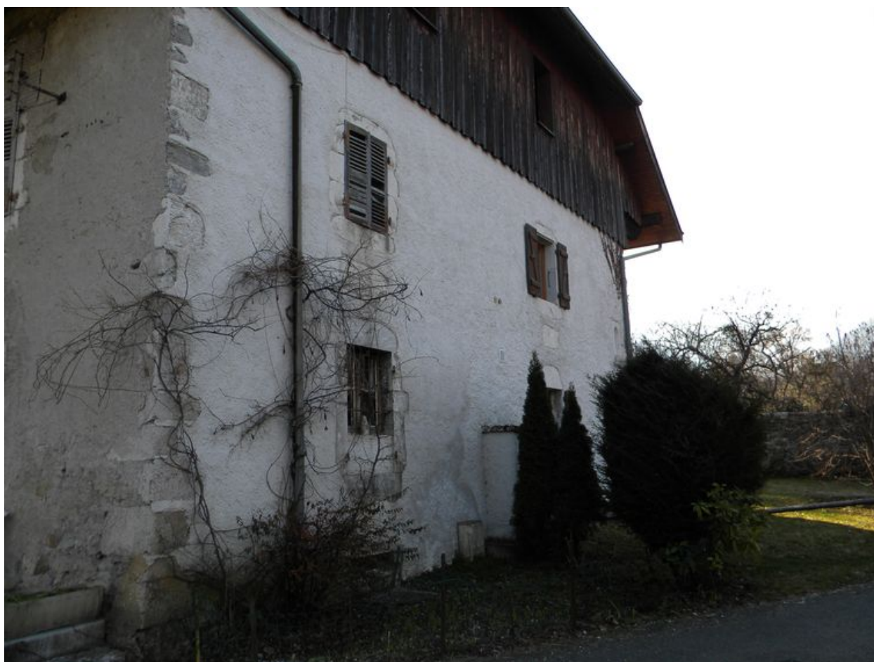
Vue de la façade ouest avec bardage bois et niche votive.
