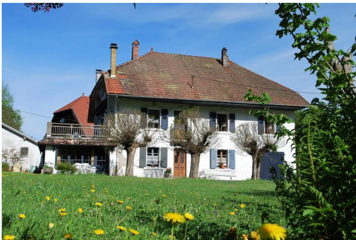
D6 339, maison. Vue d'ensemble de face.
