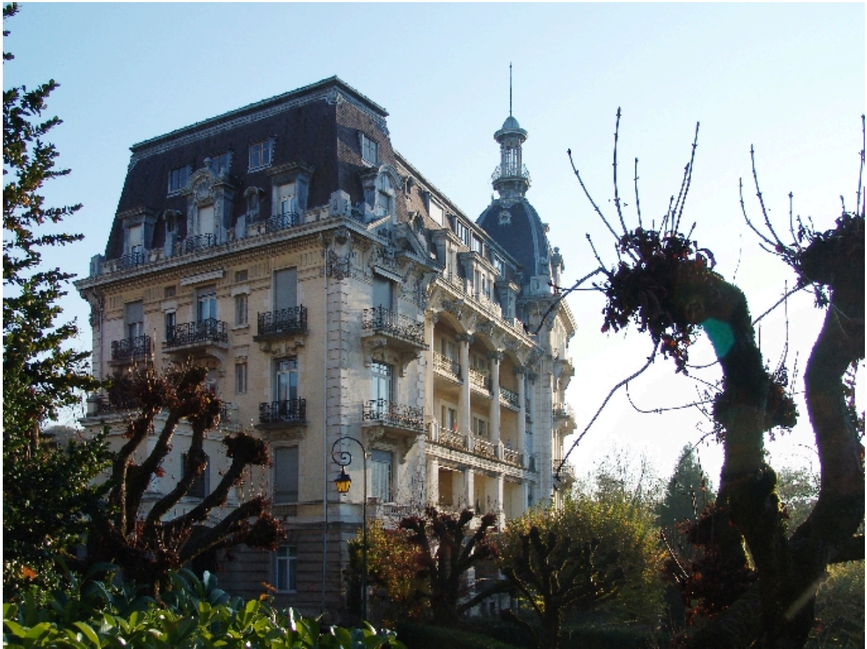
Vue d'ensemble prise du nord
