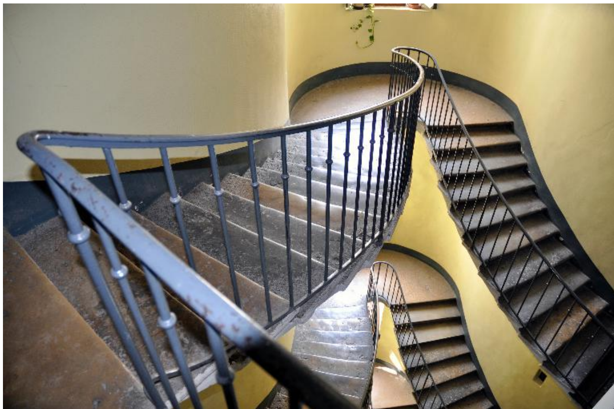
Vue générale de l'escalier
