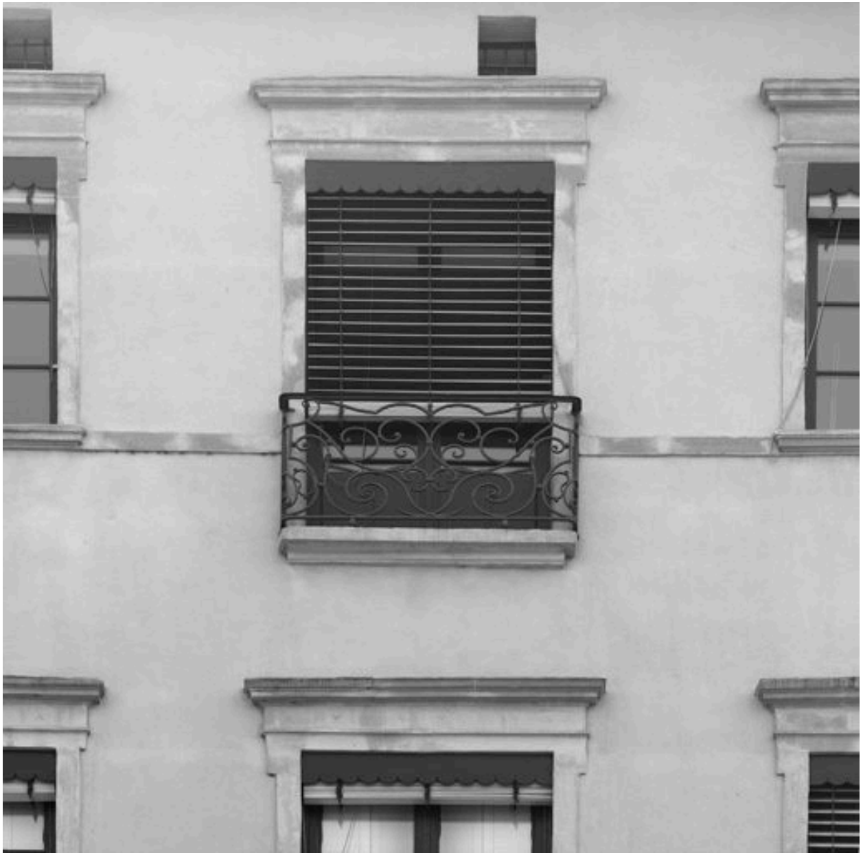
Corps de bâtiment sis à l'angle du quai Saint-Antoine et de la rue du Petit-David : balconnet du dernier étage carré
