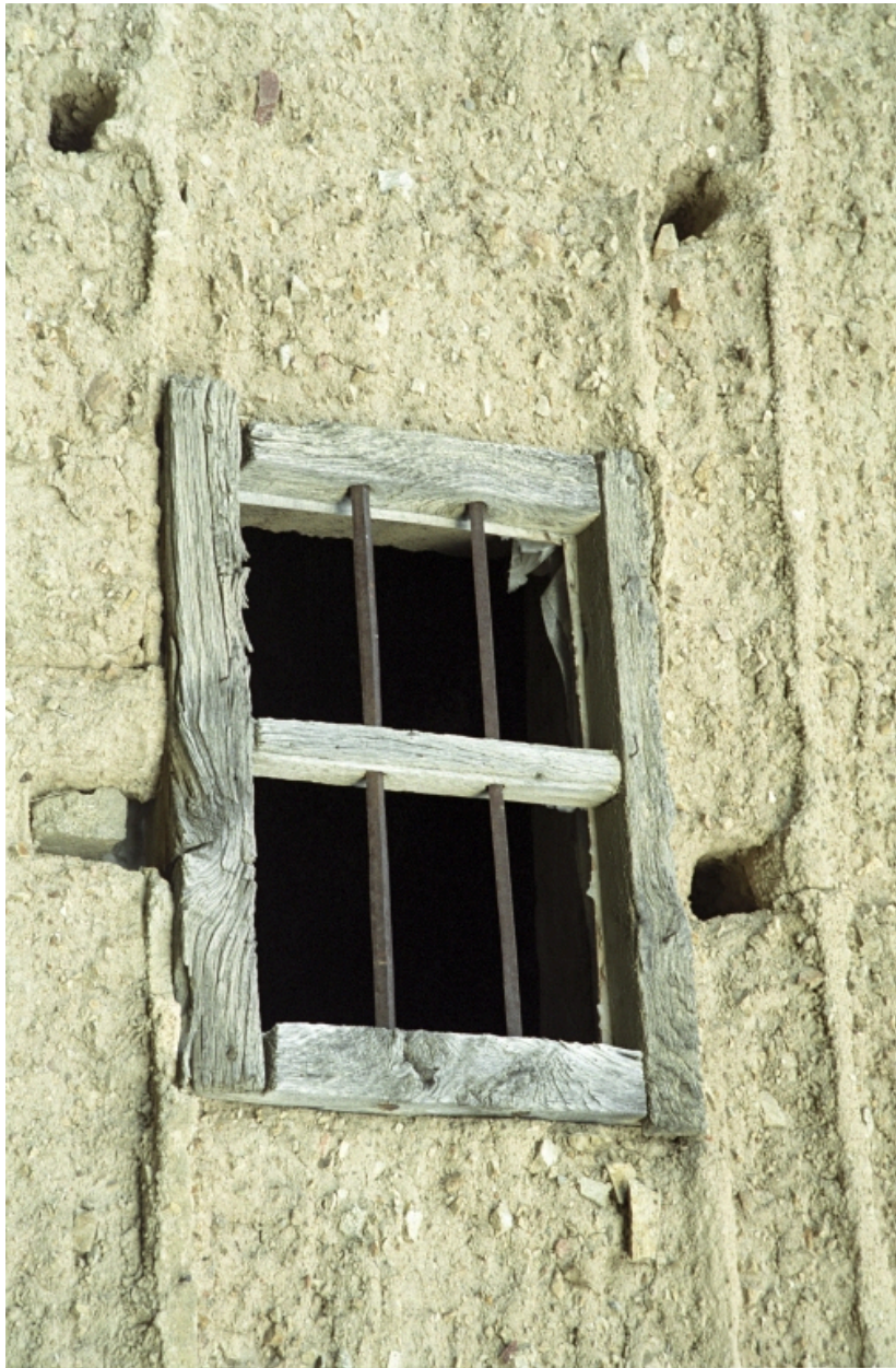
Saint-Sixte, Ciergues, loge (1987 D3 955). Jour à barreaux métalliques.
