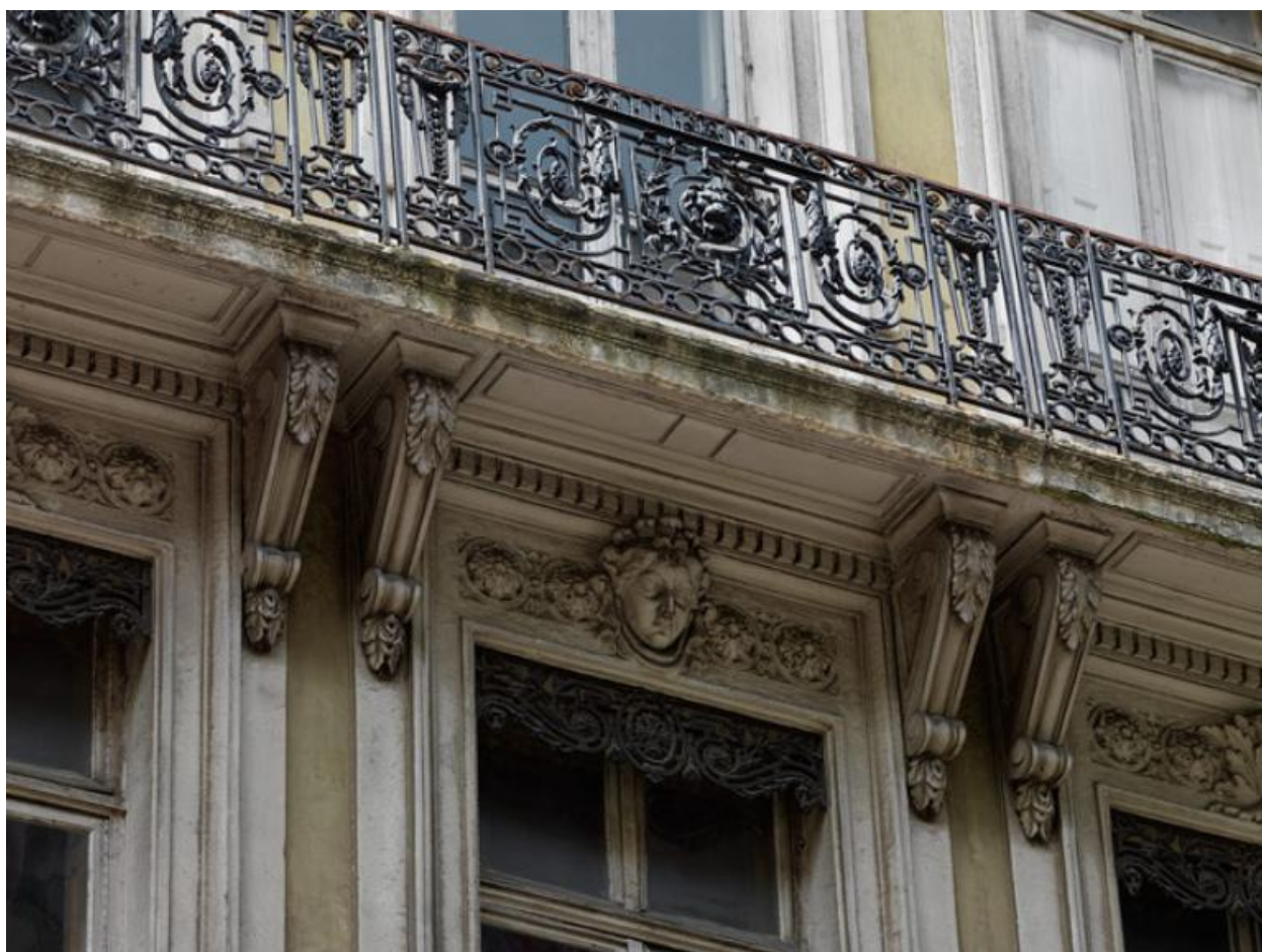
16 rue Gasparin : détail des consoles soutenant les balcons
