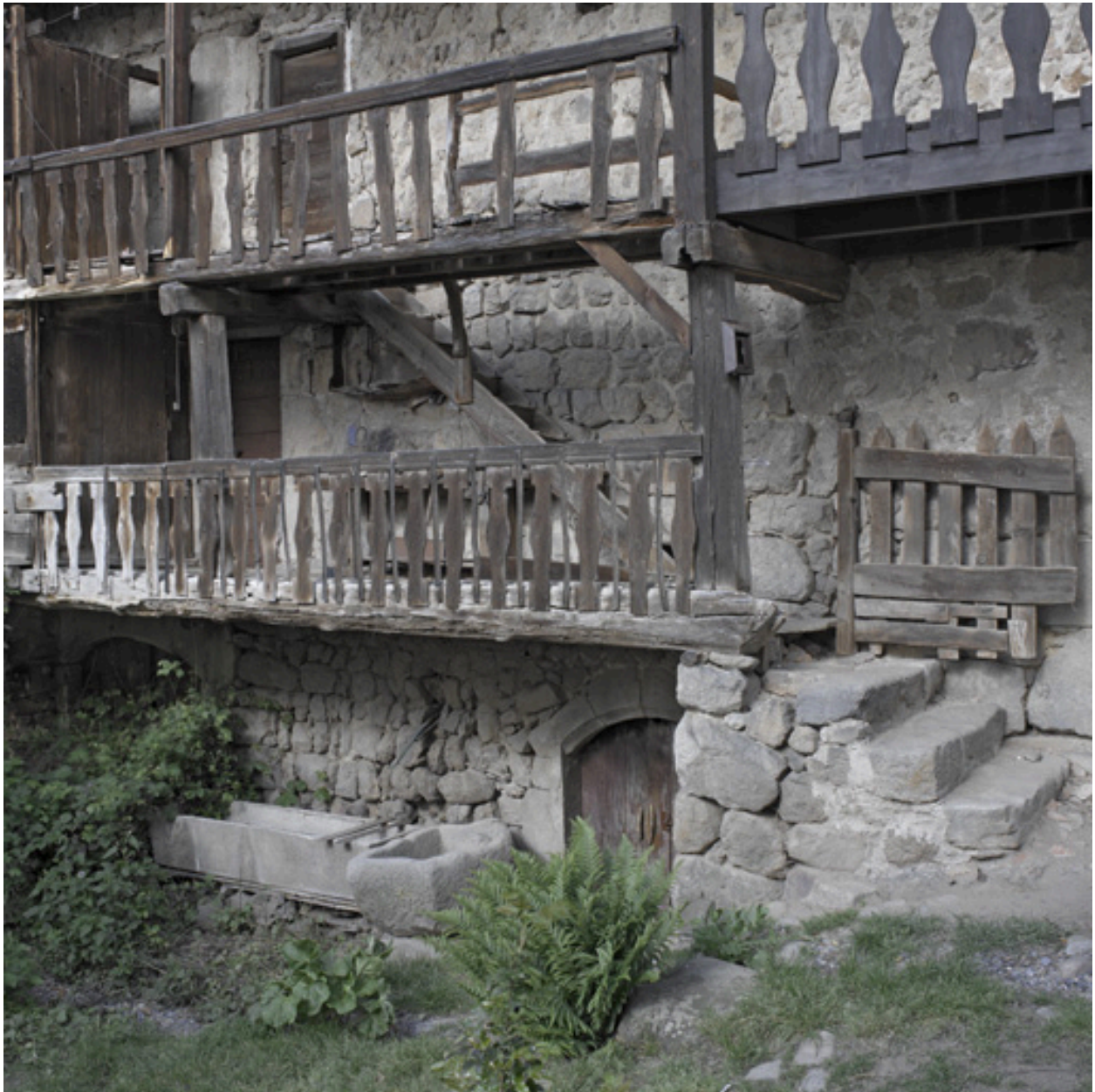
Détail des deux niveaux de galerie
