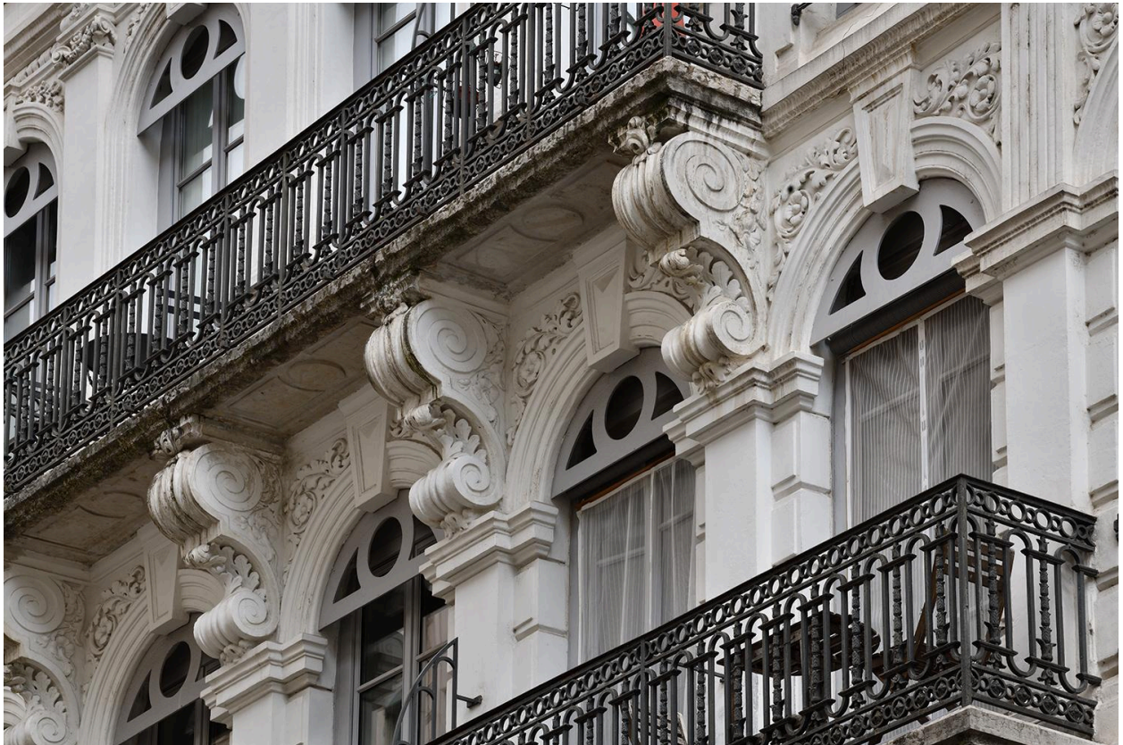
Consoles soutenant le balcon du troisième étage carré
