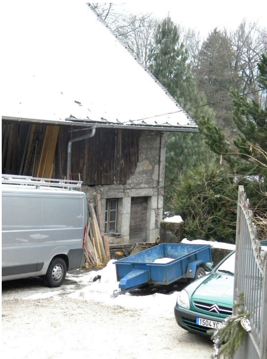
Vue de la partie habitation et du bardage de la grange.
