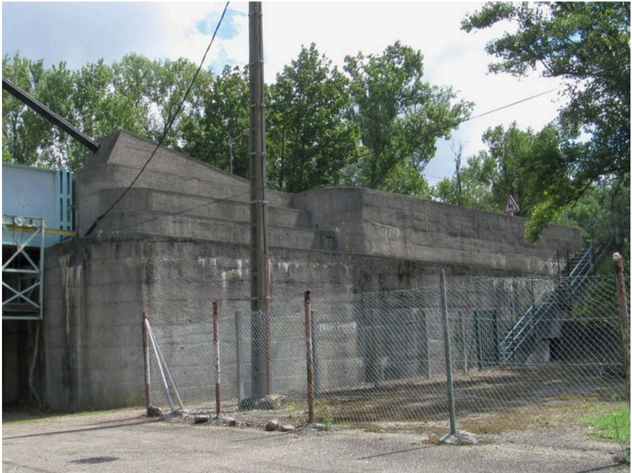
Massif d'ancrage gauche, face aval, vue générale (depuis la rive gauche)
