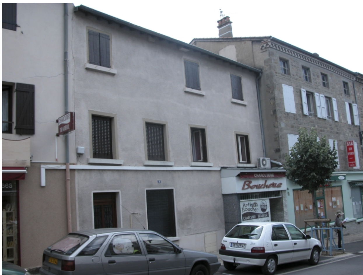
Îlot 1. République (place de la) 09. Vue d'ensemble de la façade sur la place.
