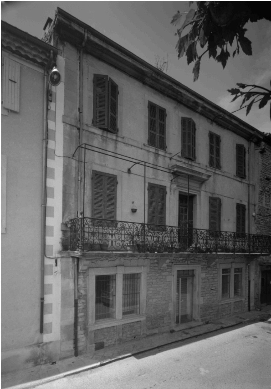
Rue des Remparts (AM 83). Maison de type 4, adossée à la courtine, façade remaniée à la fin du 19e siècle.
