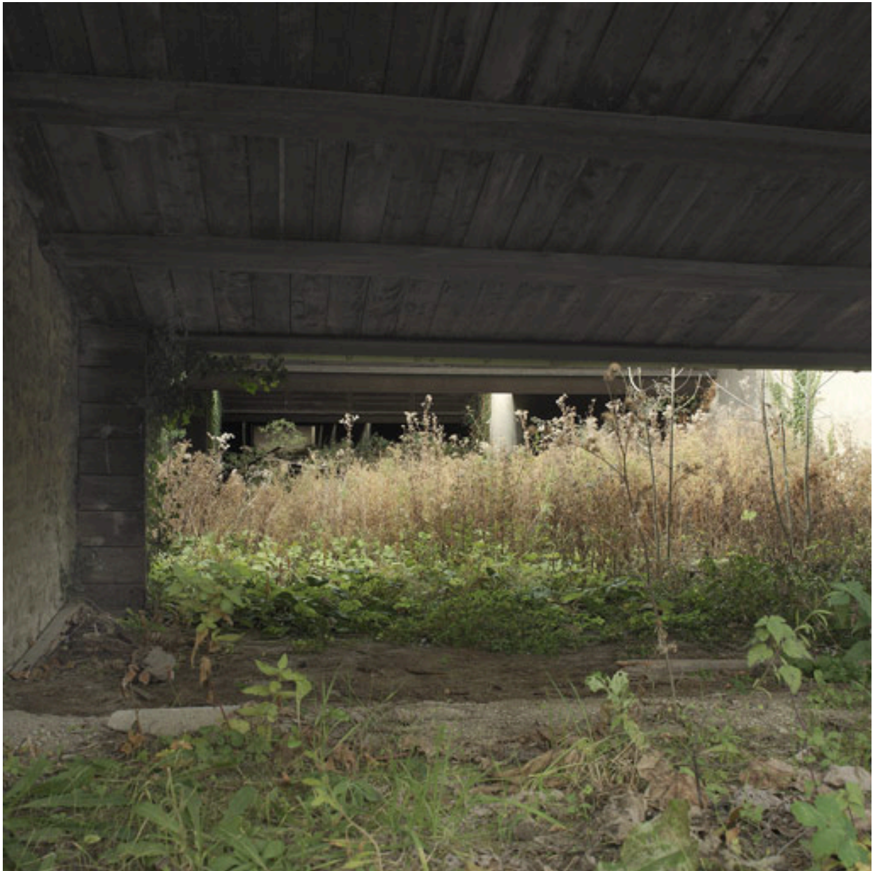
Vue intérieure partielle du stand de tir.
