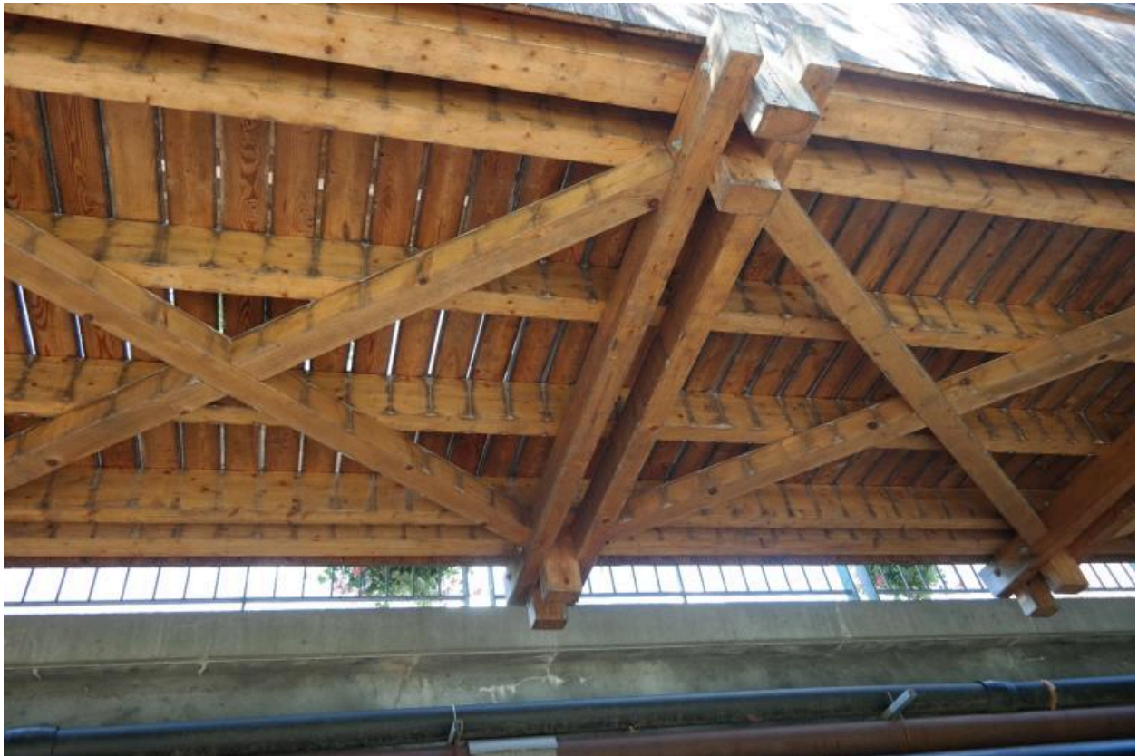
Pont du Nant de la Ville, vue du dessous de la passerelle piétonne aval
