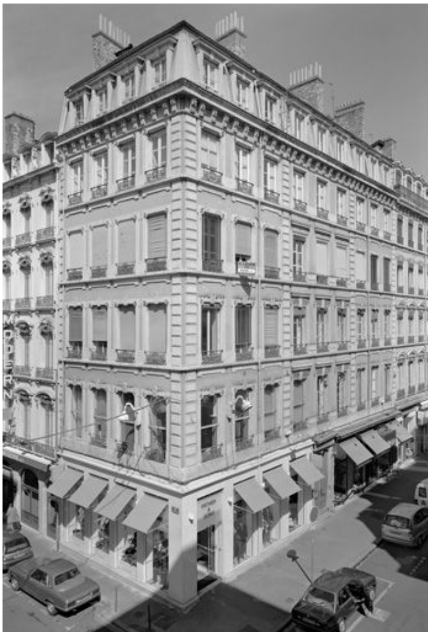
Vue générale des façades
