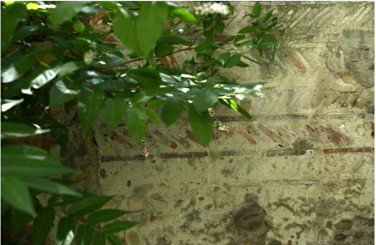
Détail de l'appareil en arêtes de poisson
