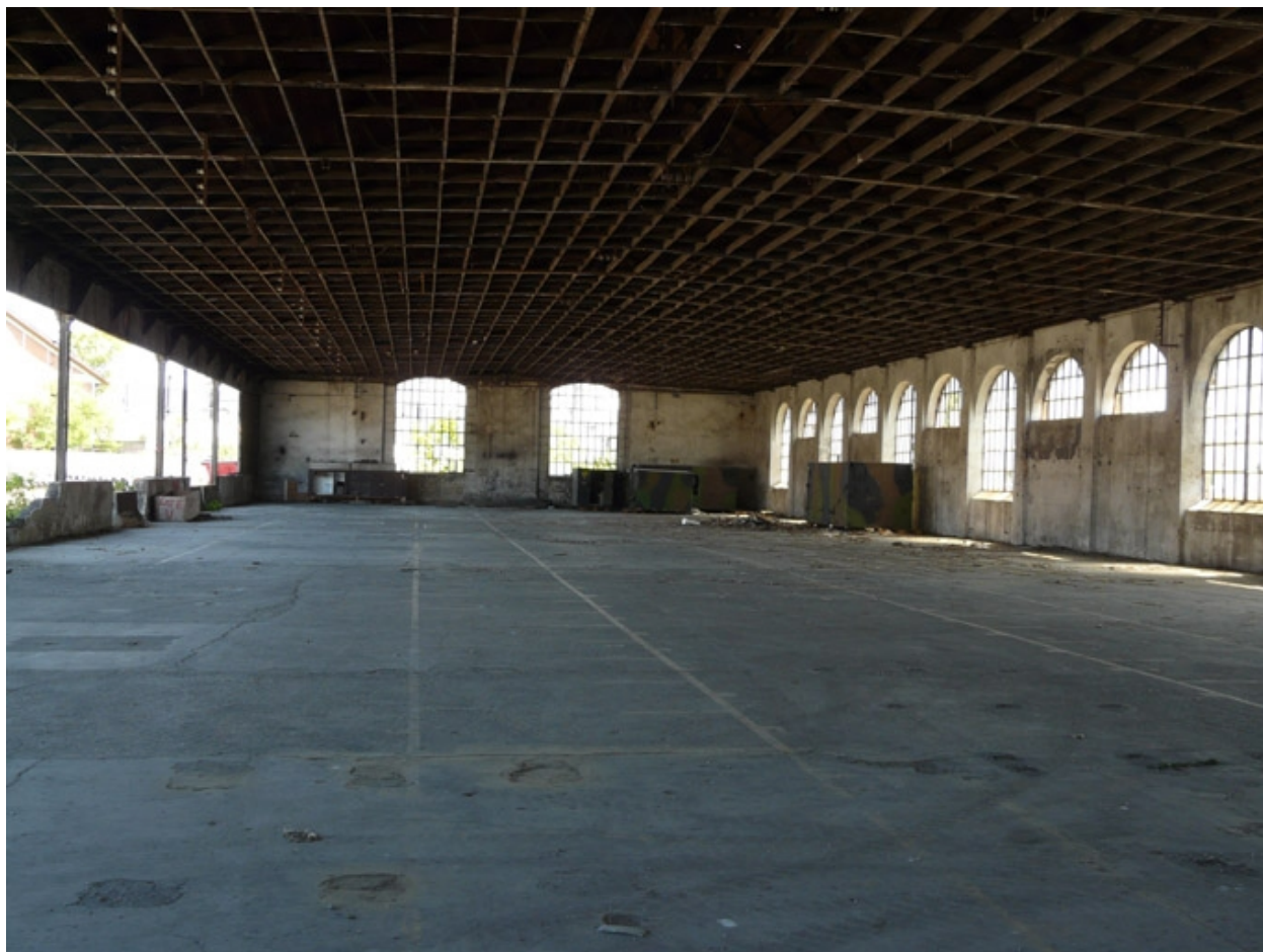
Vue d'ensemble de la grande halle qui doit être démolie
