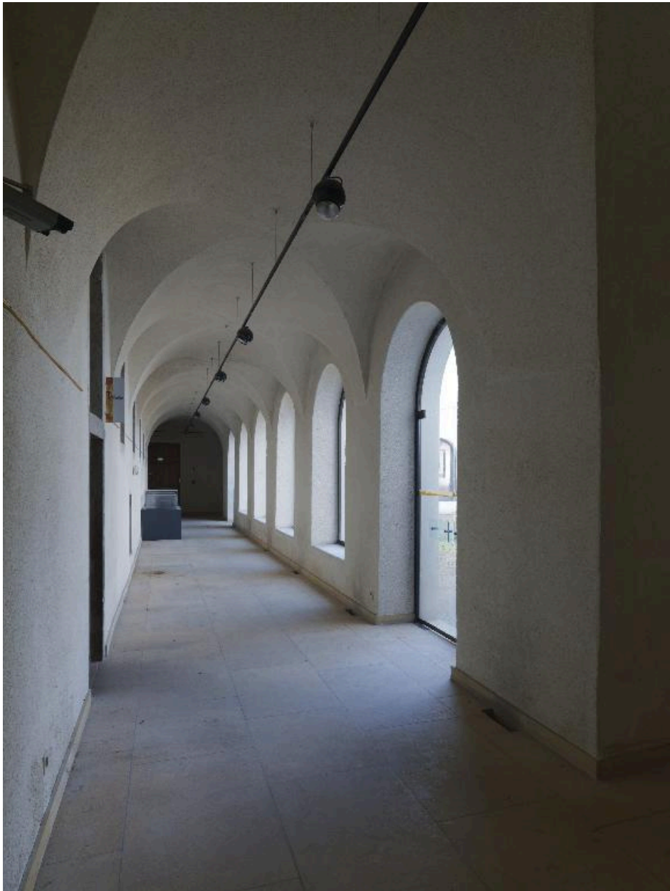
Vue de la galerie sud du cloître, depuis l'est
