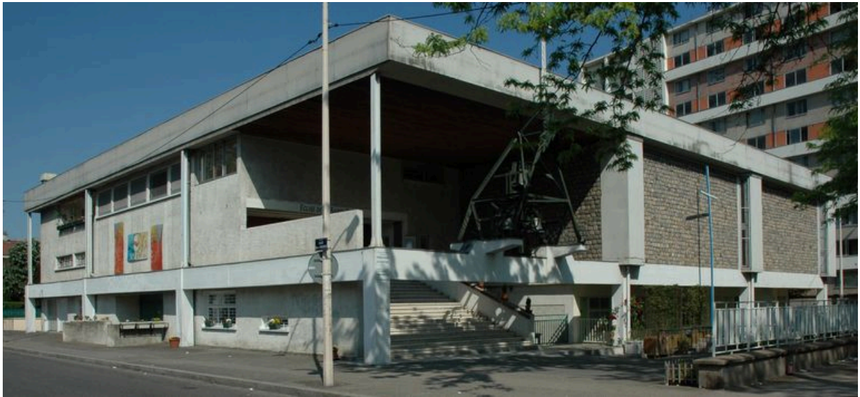
Vue générale depuis le sud-ouest
