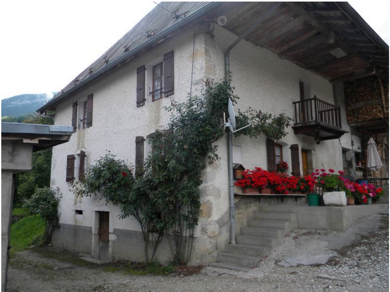
Vue de la façade ouest et de l'entrée de la cave.
