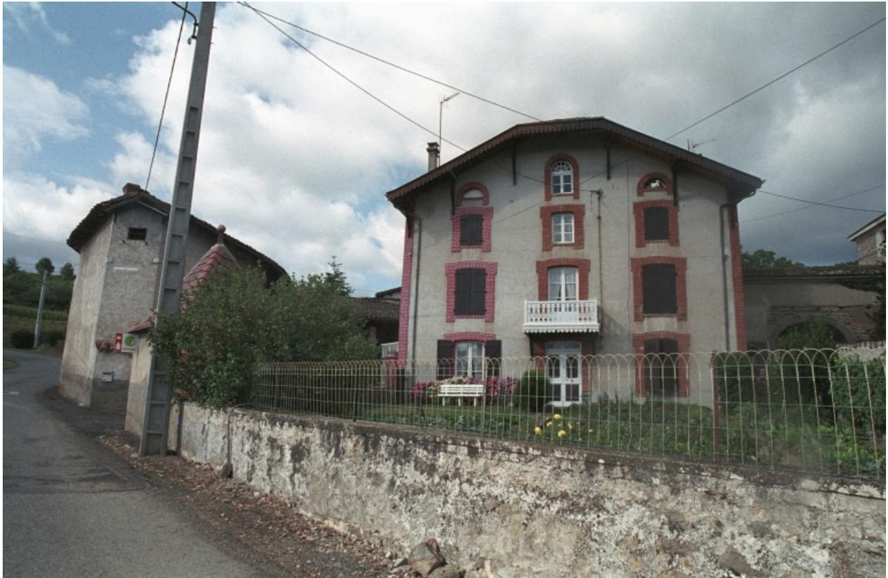
Aux Genettes, maison d'industriel (?) (1986 A 217, 218). Bâtiment en pisé, avec encadrements et chaînage d'angle en brique, toit à croupe. Vue d'ensemble de face.
