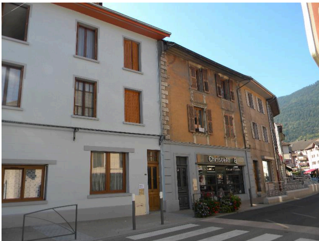
Façades rue Sadi Carnot (2008 D15 2486, 2484).
