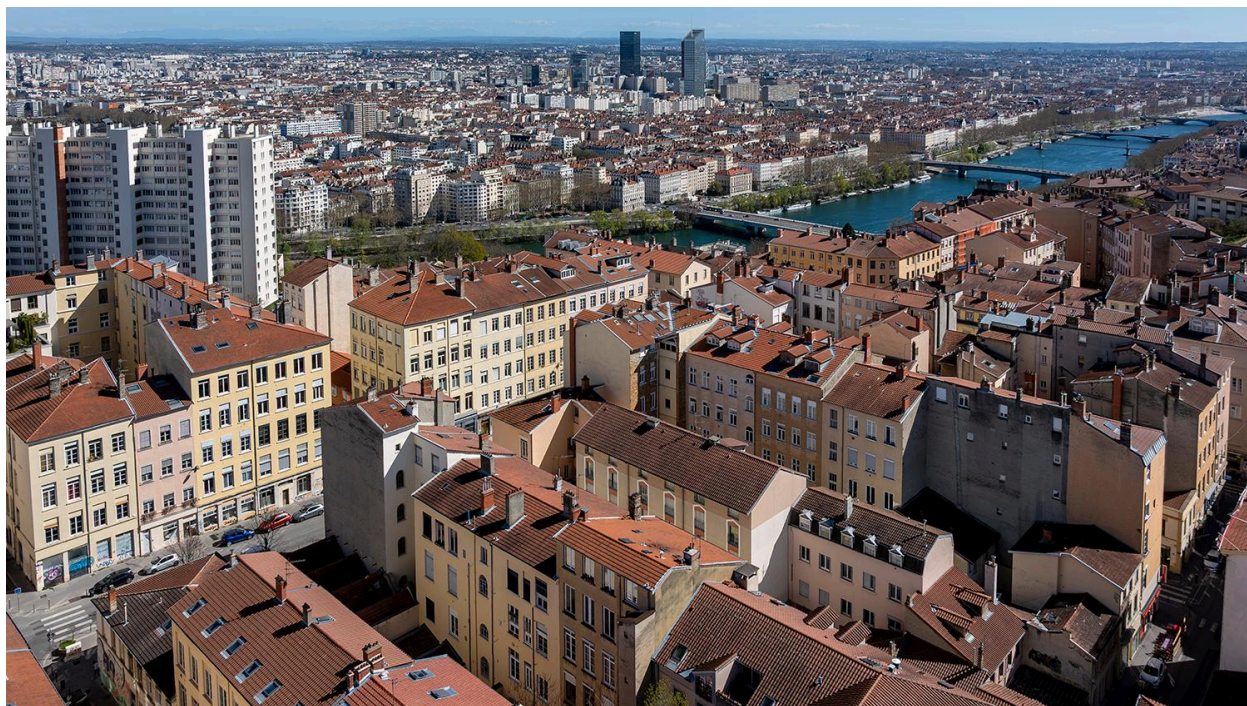
Vue d'ensemble secteur des immeubles-ateliers (vue drone)
