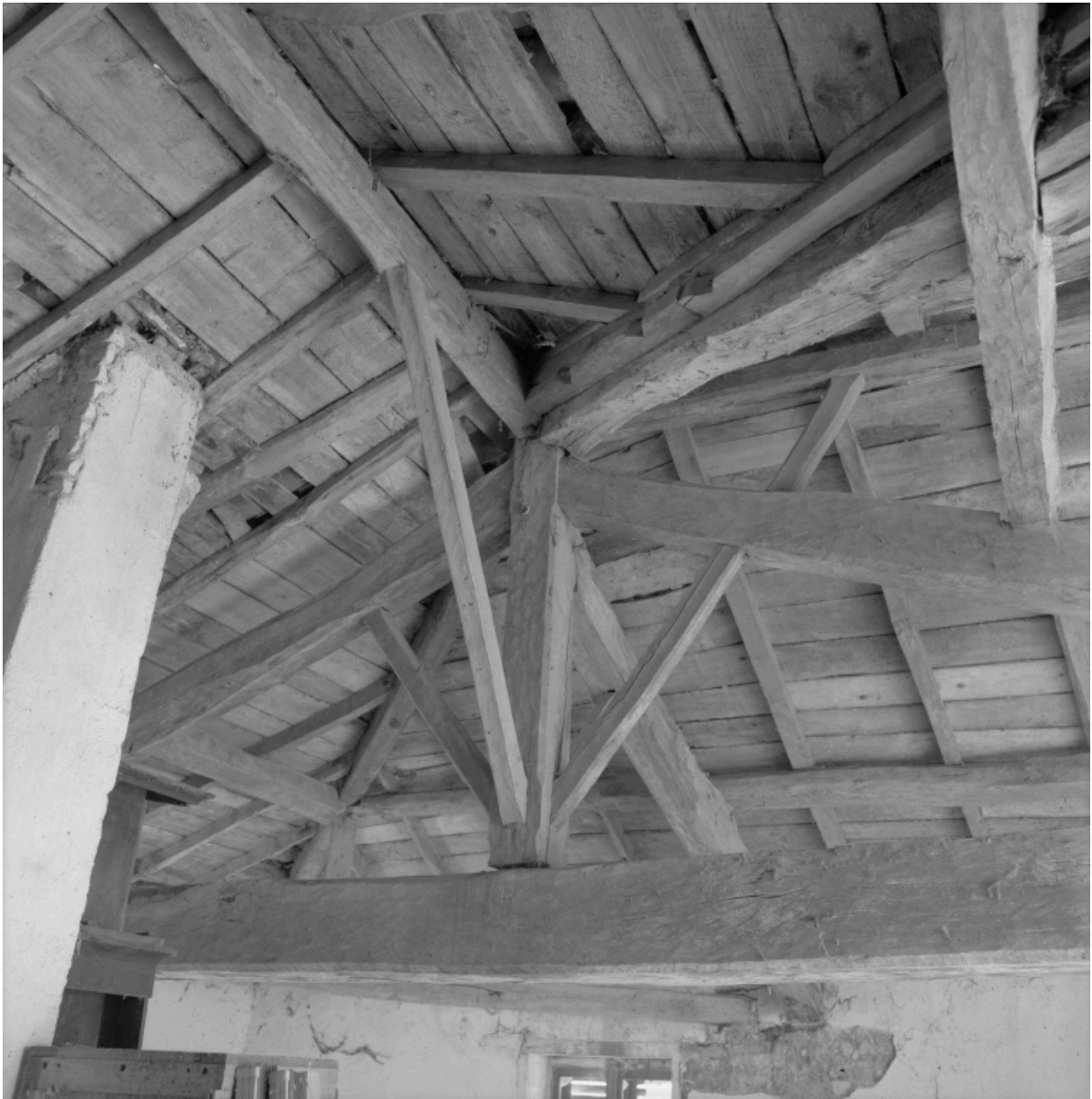
Vue intérieure, étage de comble de la maison : détail de la charpente.
