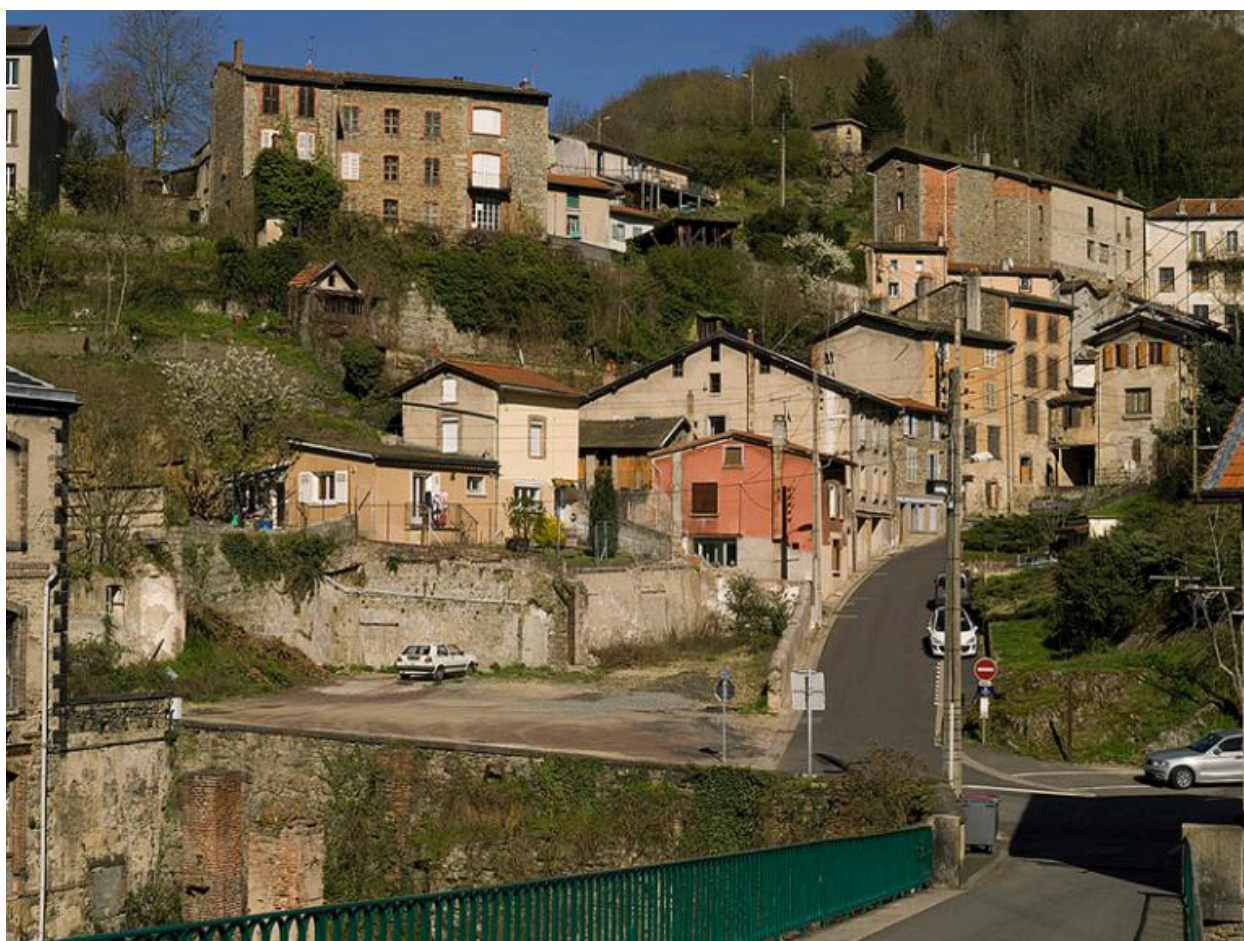
Exemple de bâti sur double pente, entre les quartiers Saint-Roch et des Papeteries.
