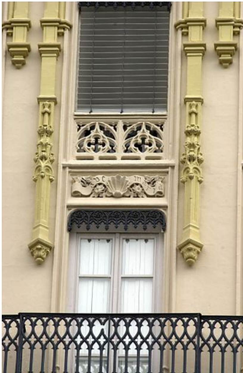
Façade principale rue Chavanne, détail de la baie axiale du 4e étage
