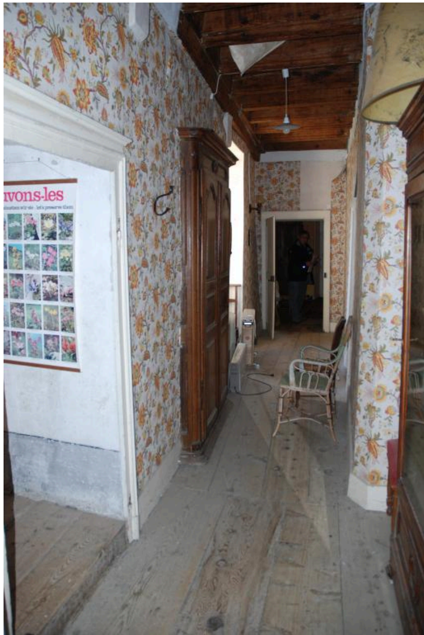
Corps principal, premier étage, partie sud, couloir (Cf. Plan étage 13), vue d'ensemble vers l'ouest.
