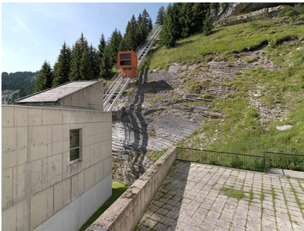
La cabine d'ascenseur
