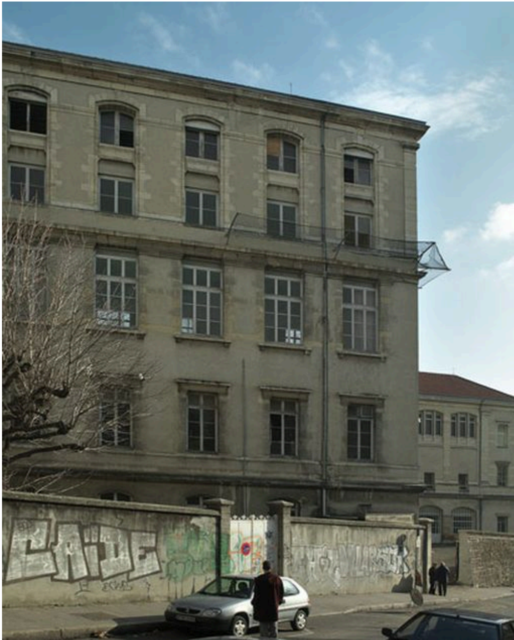
Vue de l'élévation sud-ouest du bâtiment qui abritait les cuisines au sous-sol, le réfectoire (étage de soubassement) et la salle de dessin au premier, surmonté des dortoirs.
