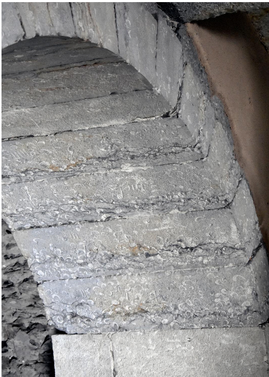
Bâtiment C, passage vers l'église : détail de l'arc avec marques de tâcheron et de pose
