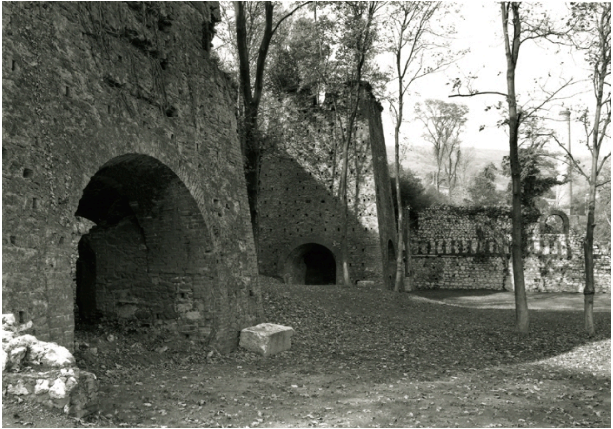
Vue des hauts fourneaux
