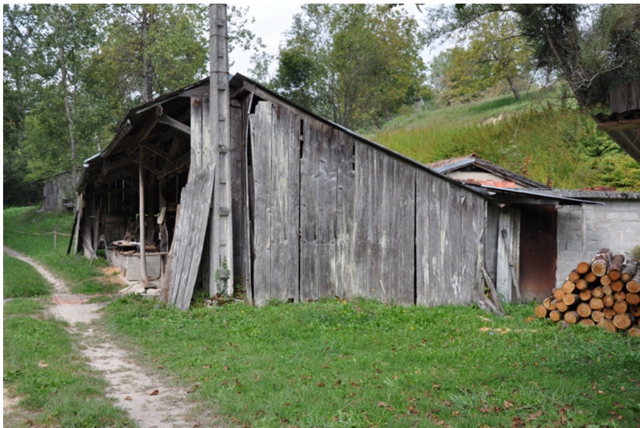
Vue de la scierie, façade est
