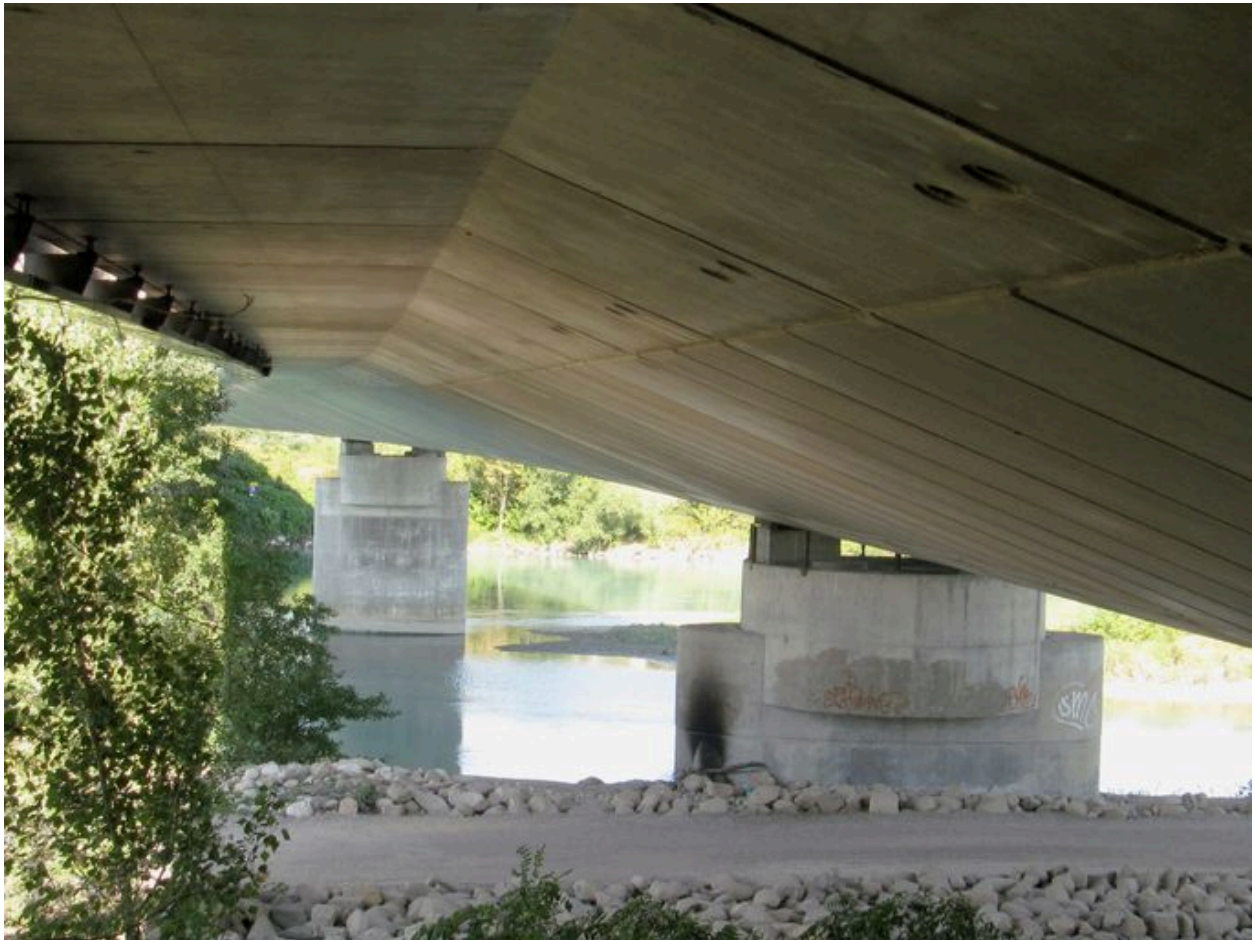
Piles et tablier, de dessous, face aval, vue générale (depuis la rive gauche)
