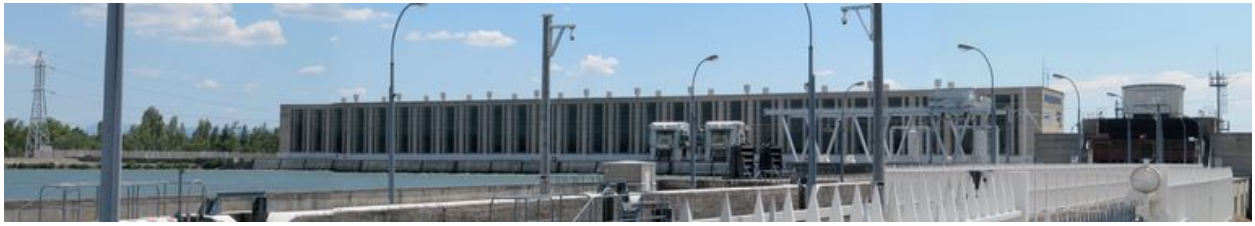
Vue panoramique, face amont (depuis la rive droite)
