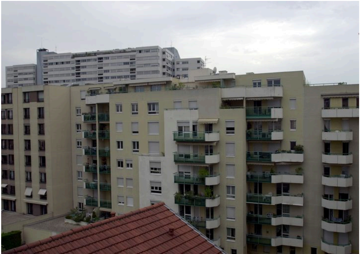
Elévation postérieure, vue partielle depuis le sud-ouest
