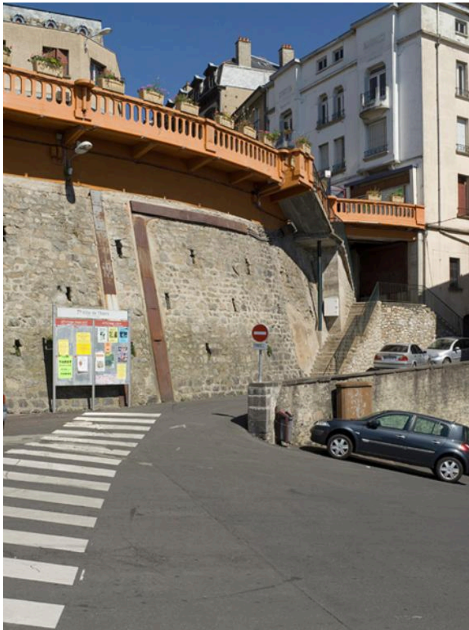
Détail du mur de soutènement du "Rempart".
